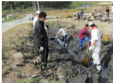
(平成 23 年 10 月 瓦礫撤去)
